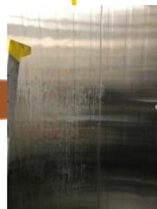
Projection corrosive sur les parois hors des bacs de rétentions et écoulement au sol
